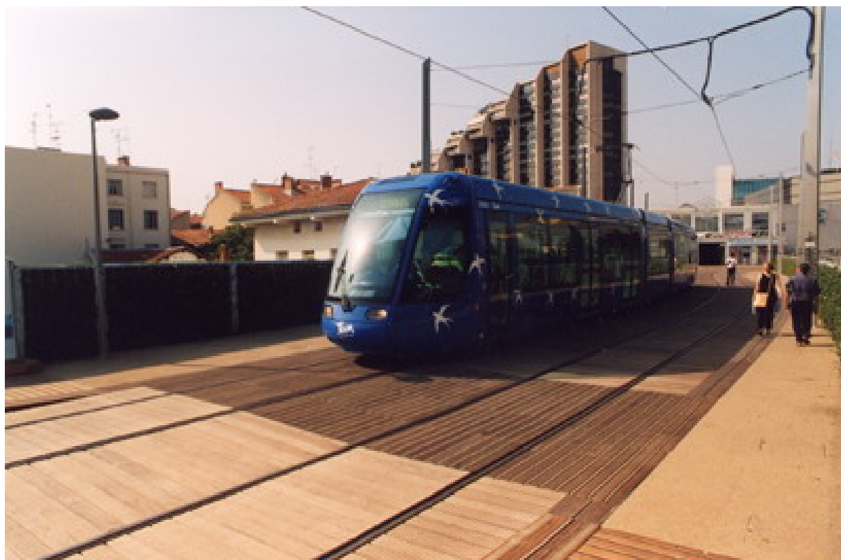
Habillage-bois des voies du tramway - Montpellier, France
